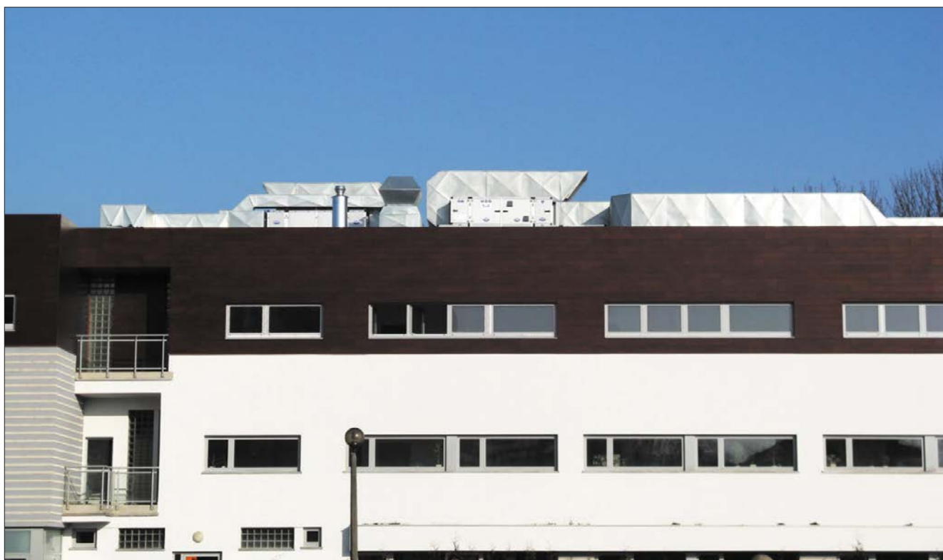
Prywatna Szkoła Podstawowa i Gimnazjum SALWATOR w Krakowie – dostawa dwóch central wentylacyjnych DNWB z odzyskiem ciepła o łącznej wydajności 19 000 m 3 /h
