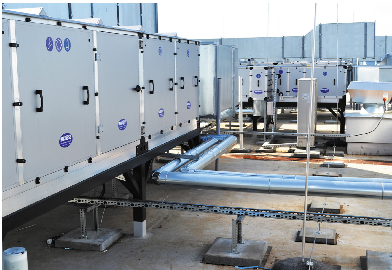
Uniwersytet Rzeszowski - Zakład Nauk o Człowieku – dostawa 4 central wentylacyjnych z odzyskiem ciepła VEBAR WS wyposażonych w wymienniki spiralne, o łącznej wydajności 16 530 m 3 /h oraz higienicznej centrali VEBAR G z wymiennikiem glikolowym o wydajności 9780 m 3 /h
