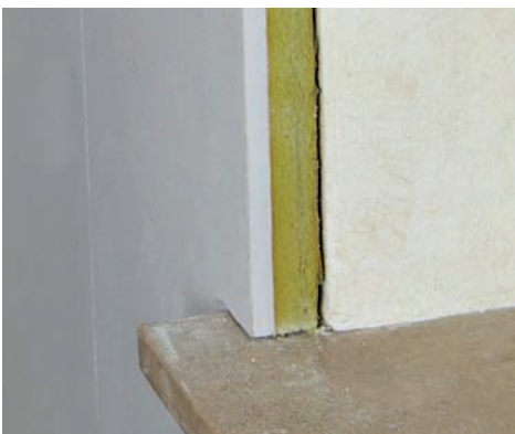
FOT. 3. Aerowetna jako izolacja od wewnątrz; fot.: Deutsche Rockwool Mineralwool [9]
