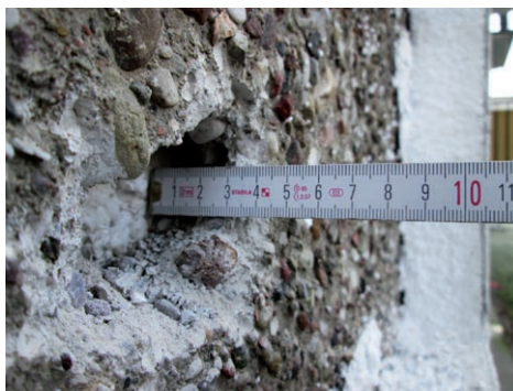
FOT. 12. Pomiar grubości płyty fakturowej (ściana w technologii WP); fot. archiwum autora
