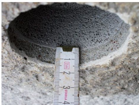
FOT. 11. Pomiar grubości warstwy nienośnych ściany – tynk zewnętrzny; fot. archiwum autora
