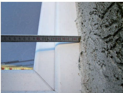
FOT. 21. Określenie szerokości ramy okiennej pod kątem możliwości ocieplenia ościeża; fot. archiwum autora
