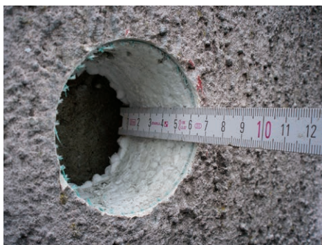
FOT. 8. Punktowy pomiar grubości ocieplenia; fot. archiwum autora
