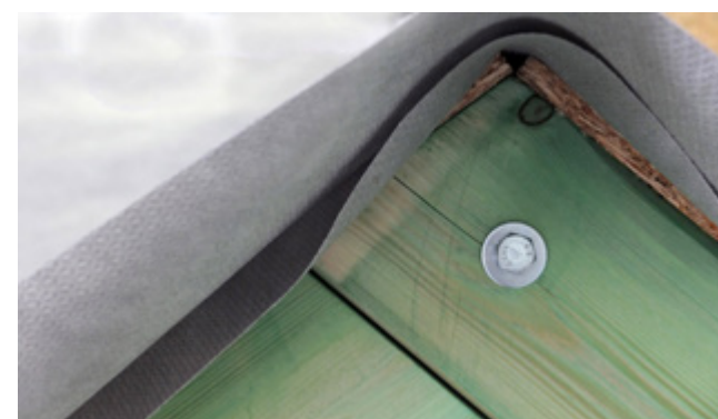
Montaż membrany dachowej mdm® Ventia
