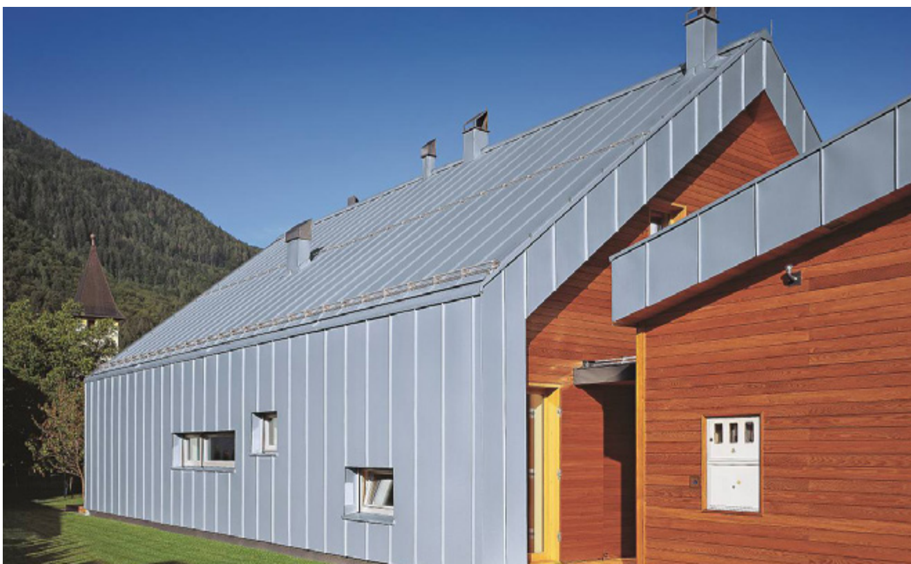
Pokrycie z blachy cynkowo-tytanowej
