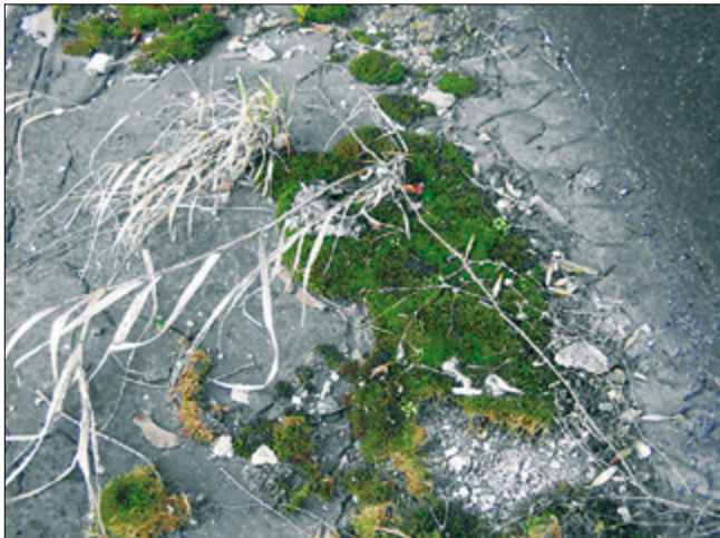
Fot. 1. Zniszczone pokrycie dachu płaskiego. Podwyższona temperatura oraz narażenie na oddziaływanie promieniowania UV i korozję biologiczną powodują znaczne skrócenie okresu trwałości pokrycia w stropodachach pełnych
