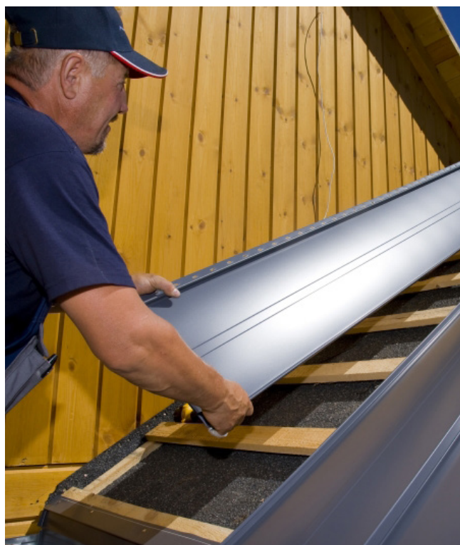
Układanie blachy na rąbek stojący
