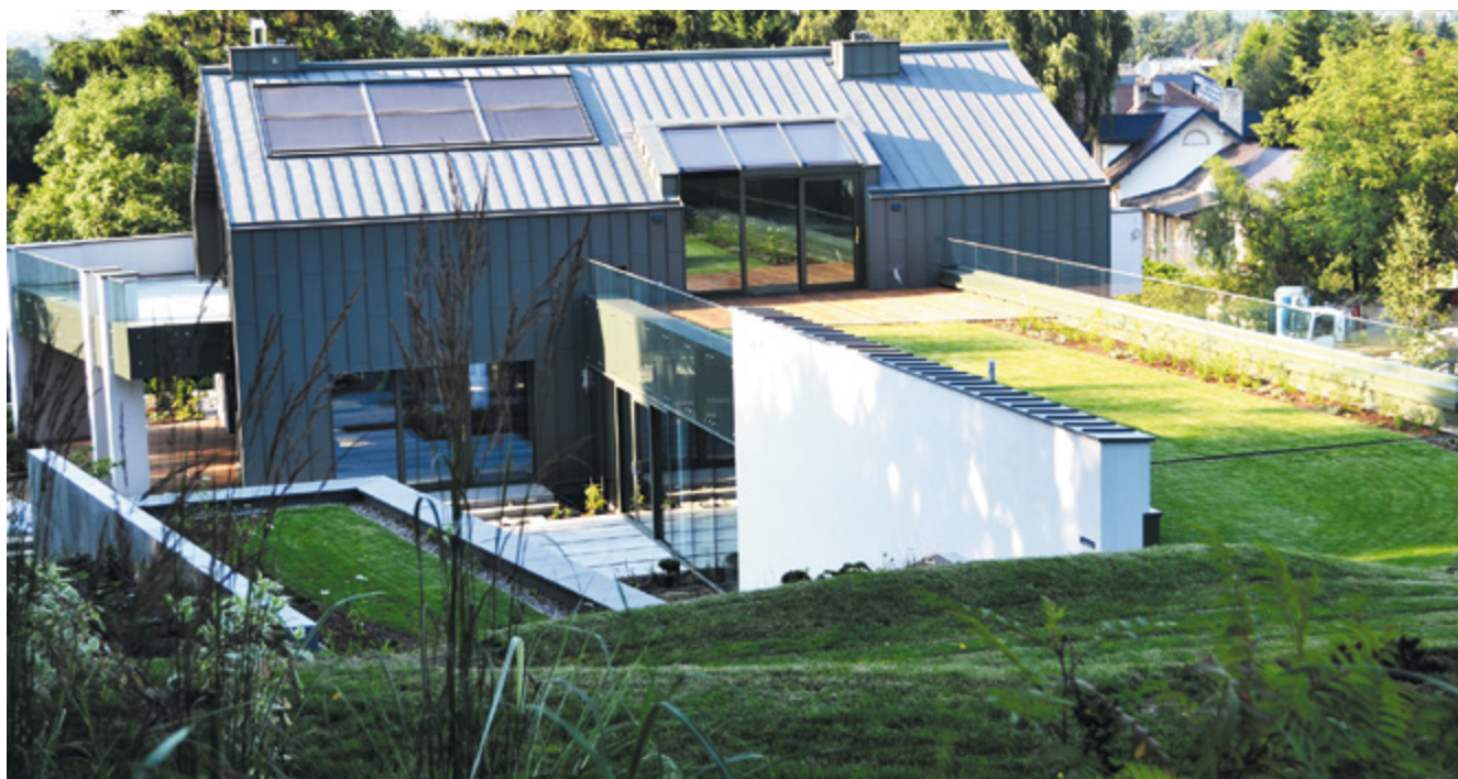
Dach zielony na rezydencji prywatnej
