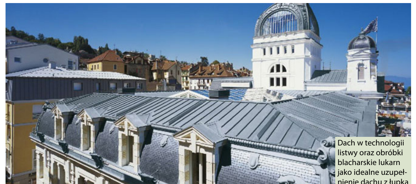
Dach ułożony na rąbek kątowy
