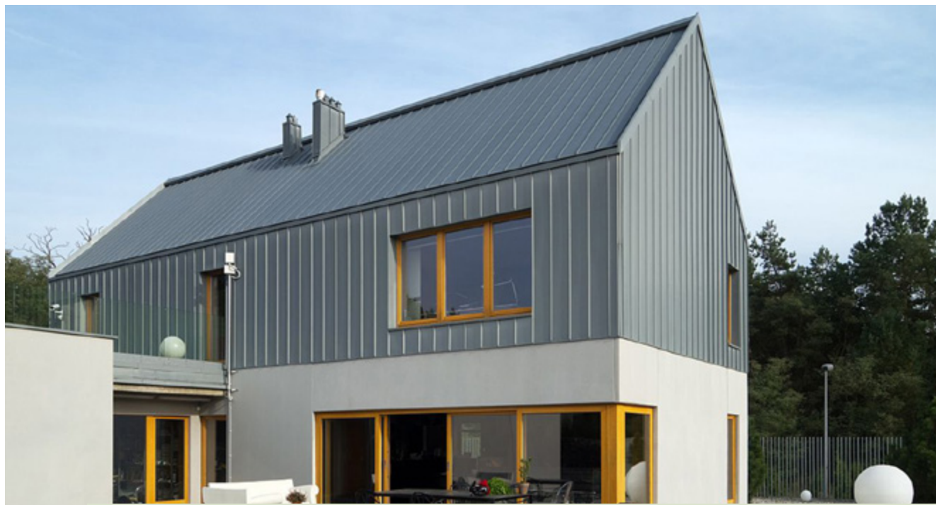
Dach w technologii rąbka podwójnego połączony z elewacją w technologii rąbka kąтового i ukrytą rynną
