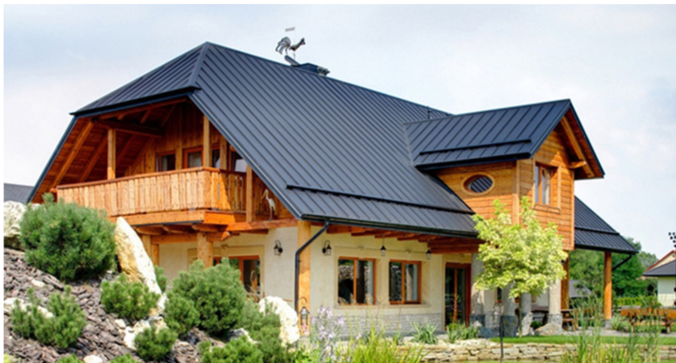
Dach pokryty blachą na rąbek stojący
