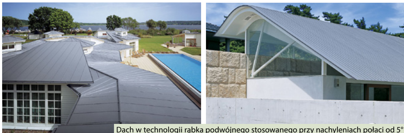
Dach w technologii rąbka podwójnego połączony z elewacją w technologii rąbka kąтового i ukrytą rynną
