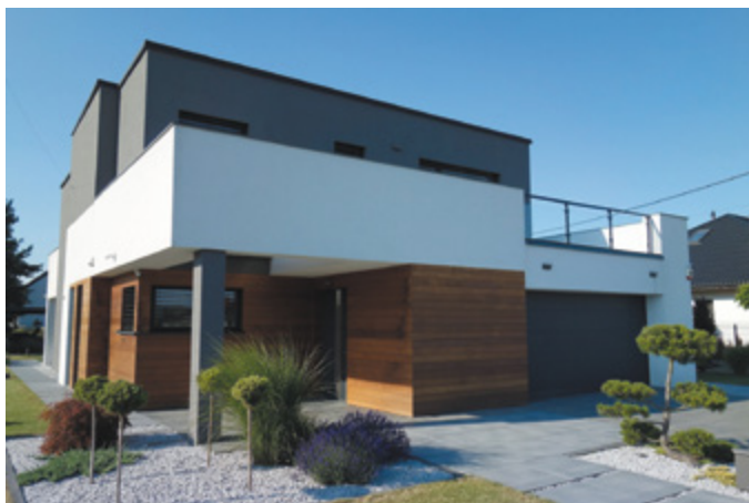
Elewacja po termomodernizacji – dekoracyjna deska w połączeniu z tynkiem silikonowym Fot. Caparol
