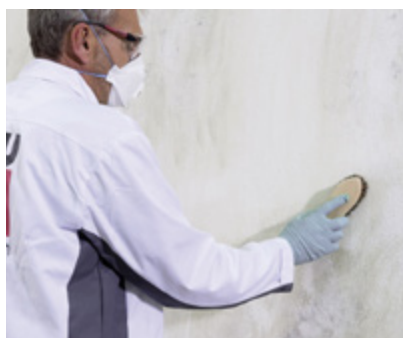
Czyszczenie elewacji Fot. Baumit
