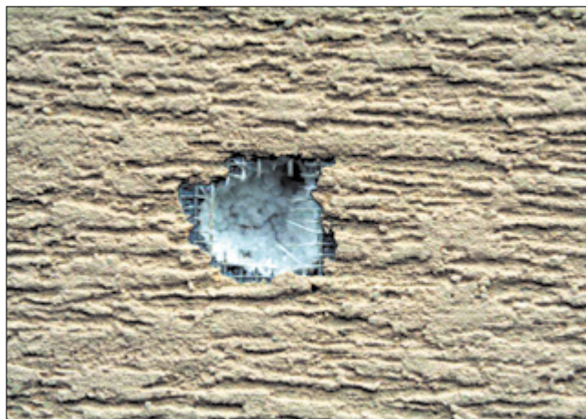
Uszkodzenia mechaniczne
