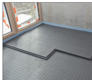
Szary styropian można stosować do izolacji podłóg
