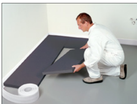
Szary styropian można stosować do izolacji podłóg
