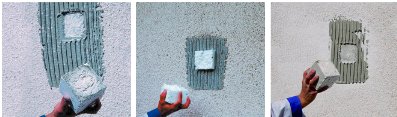
Próba przyczepności styropianu do podłoża
