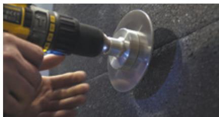
Wiercenie otworu
