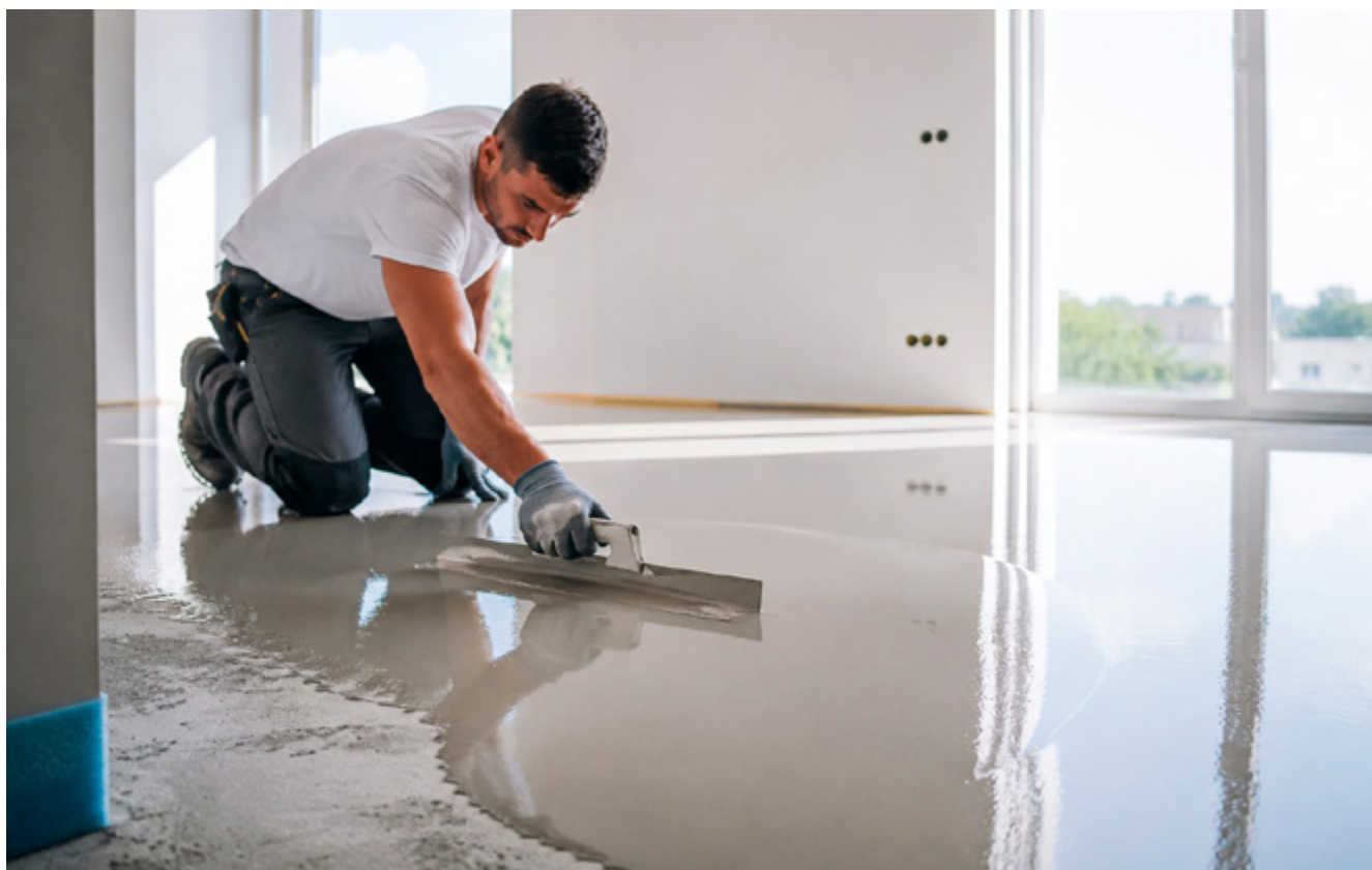
TectorFloor 451 pozwala precyzyjnie wyrównać podłoże przed montażem płytek, paneli, wykładzin lub innych okładzin podłogowych
