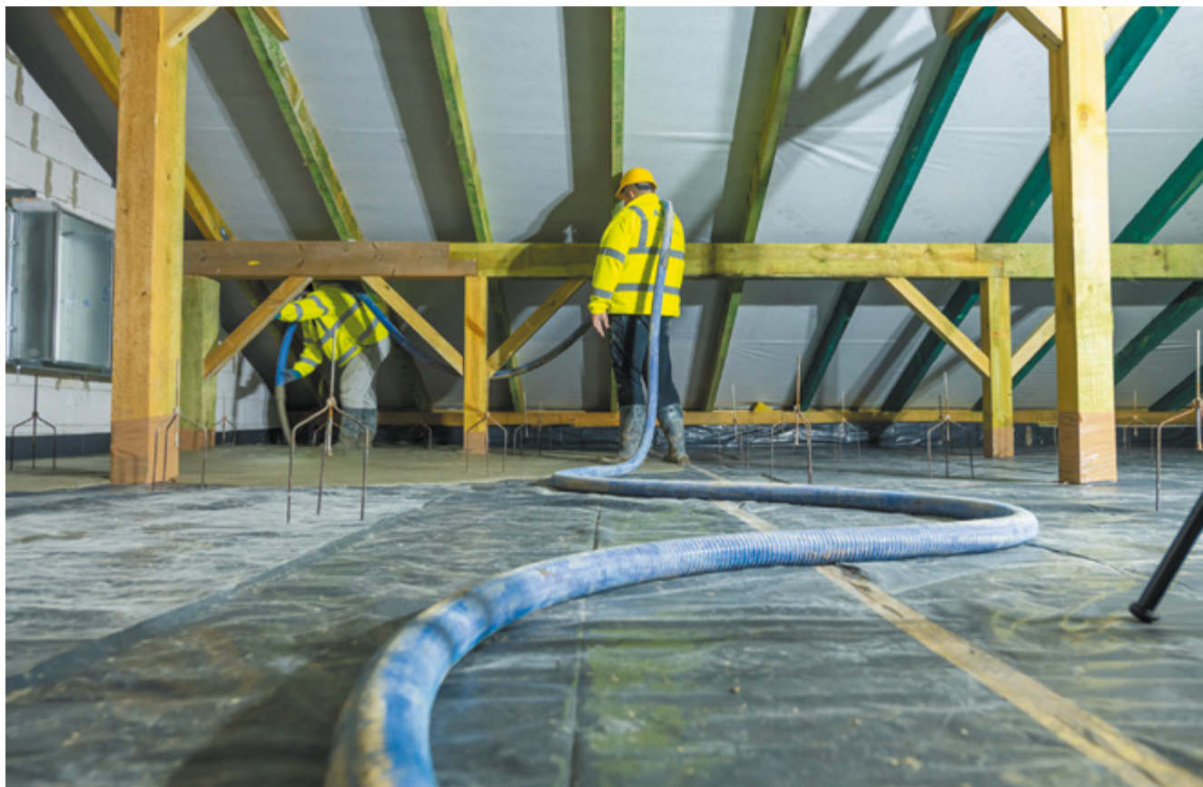
Aplikacja mineralnej piany izolacyjnej Airium na poddaszu
