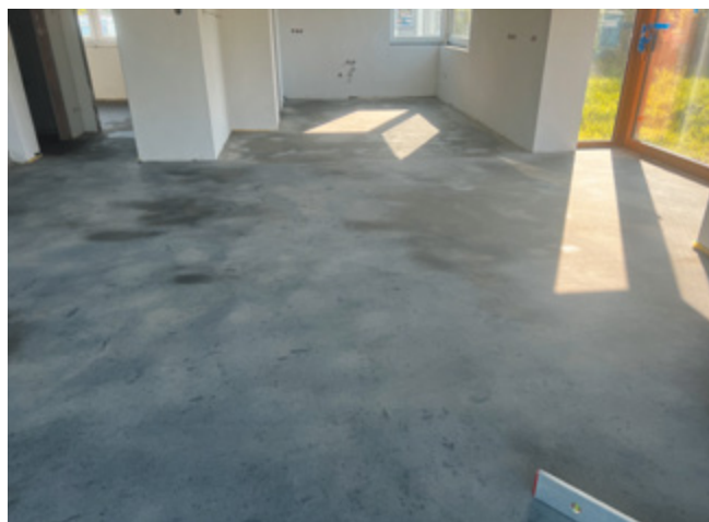
Fot. 7. Przy wykonywaniu jastrychów należy zadbać o to, by wykonać dylatacje: od ścian, robiąc podziały dużych powierzchni i w przejściach – w otworach drzwiowych oraz wykonując tzw. tetki lub kurze łapki przy narożnikach zewnętrznych Fot.: autor
