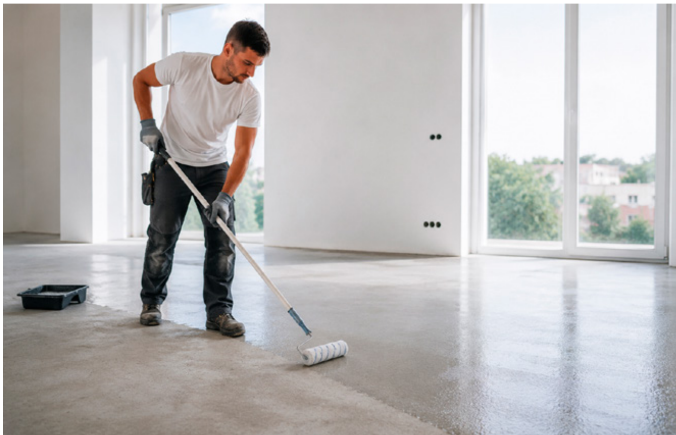
Grunтовanie pomaga przygotować podłoże pod kolejne warstwy i ogranicza ryzyko problemów z przyczepnością
