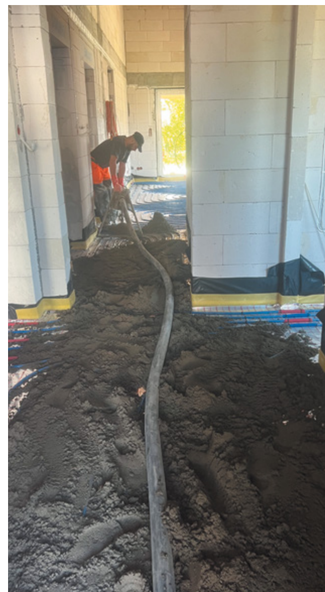
Fot. 3. Warstwa jastrychu powinna mieć odpowiednią grubość. Zazwyczaj jest to 5–7 cm Fot.: autor
