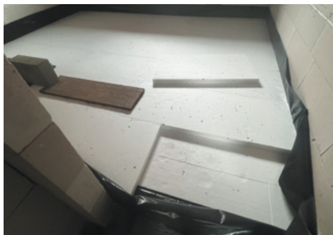
Fot. 1. Najczęściej w podłogach stosuje się styropian typu podłoga/dach. Istotne jest ułożenie styropianu by zachować przesunięcie łączów względem siebie (tzw. na cegielkę) Fot.: autor
