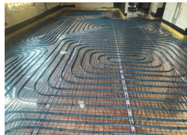
Fot. 6. Przed wykonaniem jastrychu należy zrobić próbę ciśnieniową instalacji ogrzewania podłogowego Fot.: autor
