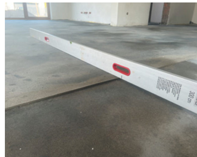
Fot. 5. Różnica poziomów jastrychu w miejscach, w których będą innego rodzaju okładziny podłogowe Fot.: autor
