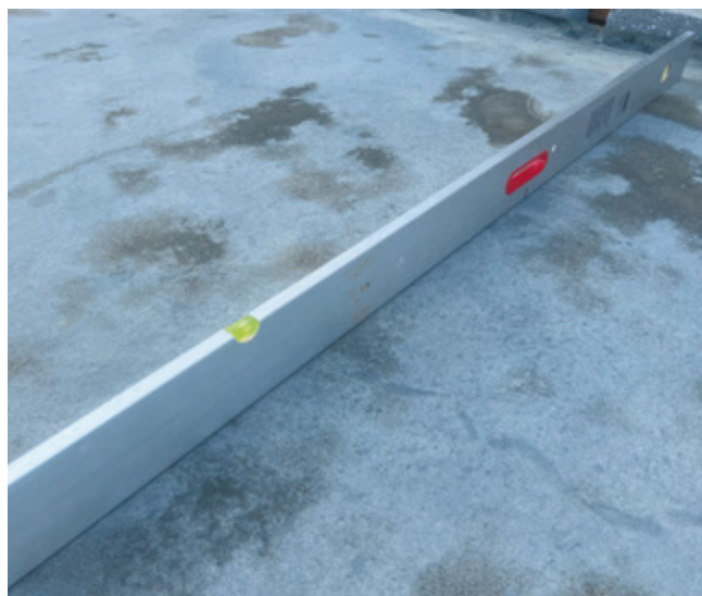
Fot. 4. Kontrola równości powierzchni jastrychu Fot.: autor
