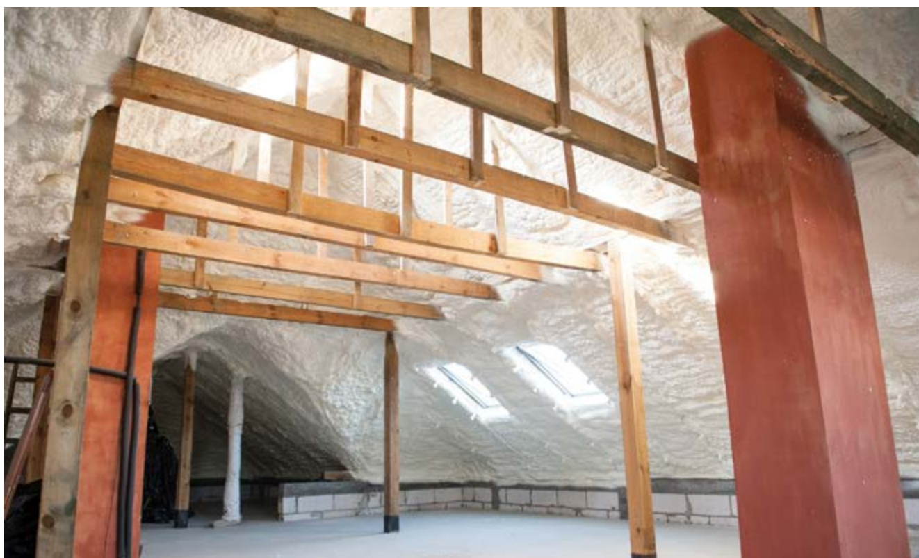
Szczelnie, bezpiecznie i trwale – izolacja poddasza pianą PUR
