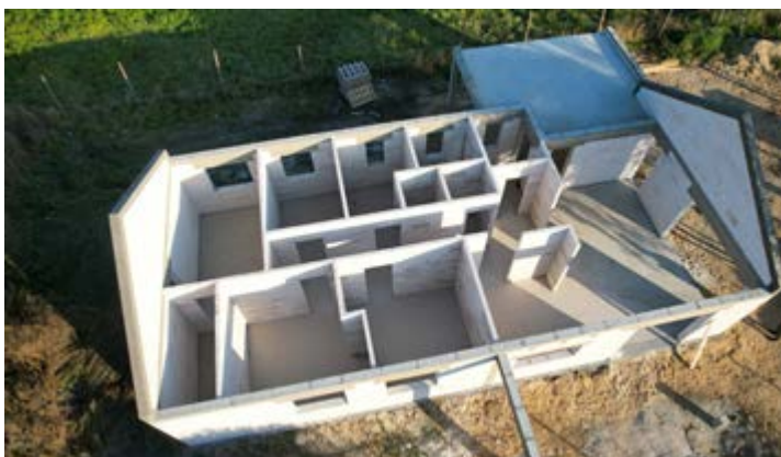
Łatwa konstrukcja to niższe koszty budowy
