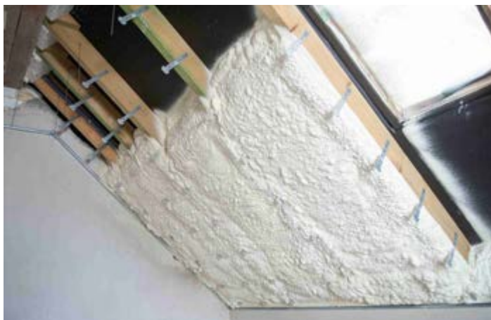
Ściana poddasza z położoną izolacją
