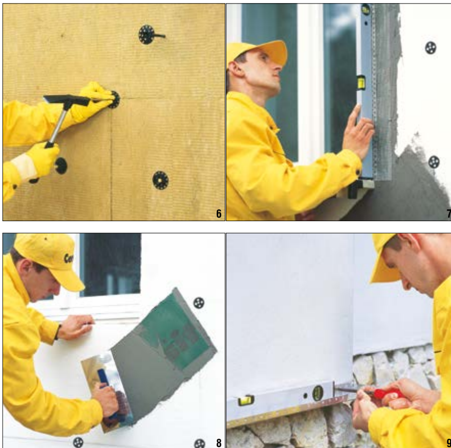
Fot. 6–9. Wybrane etapy prac przy montażu systemów ociepleń: 6 – wspomagające kotwienie, 7–8 – wklejanie siatki (7 – wklejanie profilu w naroże okna, 8 – dodatkowe wzmocnienie siatką strefy przyokiennej), 9 – mocowanie listwy startowej
