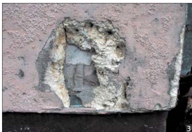
Usterki na ocieplonych elewacjach wymagające naprawy: 1 – odspojenie w warstwie zbrojonej, 2 – uszkodzenie mechaniczne spowodowane przez uderzenie twardym przedmiotem, 3 – uszkodzenie mechaniczne, 4 – Uszkodzenia spowodowane przez gradobicie
