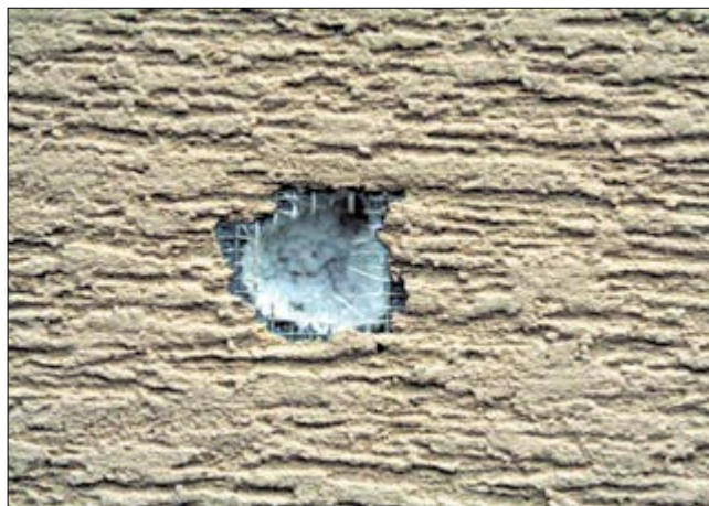
Uszkodzenia mechaniczne
