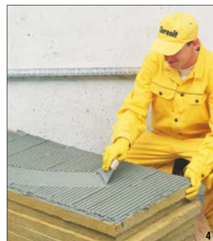
Fot. 1–5. Wybrane etapy prac przy montażu systemów ociepleń: 1 – kontrola stanu nośności podłoża, 2 – gruntowanie nasiąkliwego podłoża, 3–4 – nakładanie zaprawy klejowej na płytę dociepleniową (3 – metodą punktową, 4 – pacą ząbkowaną), 5 – przyklejanie płyt izolacyjnych
