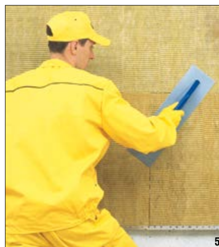
Fot. 1–5. Wybrane etapy prac przy montażu systemów ociepleń: 1 – kontrola stanu nośności podłoża, 2 – gruntowanie nasiąkliwego podłoża, 3–4 – nakładanie zaprawy klejowej na płytę dociepleniową (3 – metodą punktową, 4 – pacą ząbkowaną), 5 – przyklejanie płyt izolacyjnych
