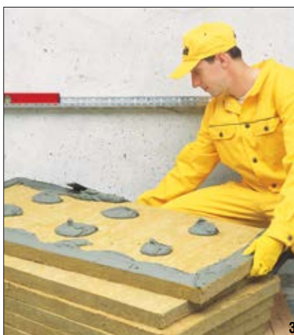
Fot. 1–5. Wybrane etapy prac przy montażu systemów ociepleń: 1 – kontrola stanu nośności podłoża, 2 – gruntowanie nasiąkliwego podłoża, 3–4 – nakładanie zaprawy klejowej na płytę dociepleniową (3 – metodą punktową, 4 – pacą ząbkowaną), 5 – przyklejanie płyt izolacyjnych
