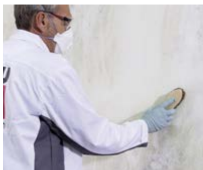
Czyszczenie elewacji Fot. Baumit
