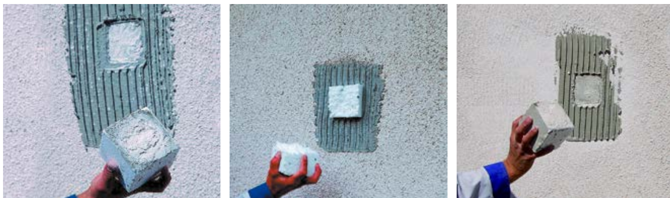
Próba przyczepności styropianu do podłoża
