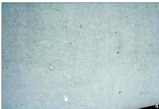
Usterki na ocieplonych elewacjach wymagające naprawy: 1 – odspojenie w warstwie zbrojonej, 2 – uszkodzenie mechaniczne spowodowane przez uderzenie twardym przedmiotem, 3 – uszkodzenie mechaniczne, 4 – Uszkodzenia spowodowane przez gradobicie
